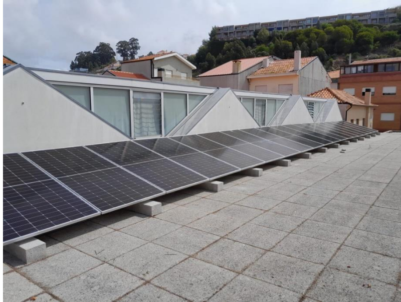
Figura 1 – Módulos fotovoltaicos do Centro Interpretativo
