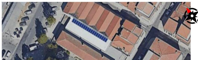
Figura 2 – Localização dos módulos fotovoltaicos na cobertura do Centro Interpretativo da Afurada
