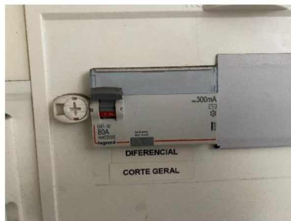
Figura 10 – Disjuntor diferencial do quadro elétrico do Mercado da Afurada – poder de corte de 80A.
