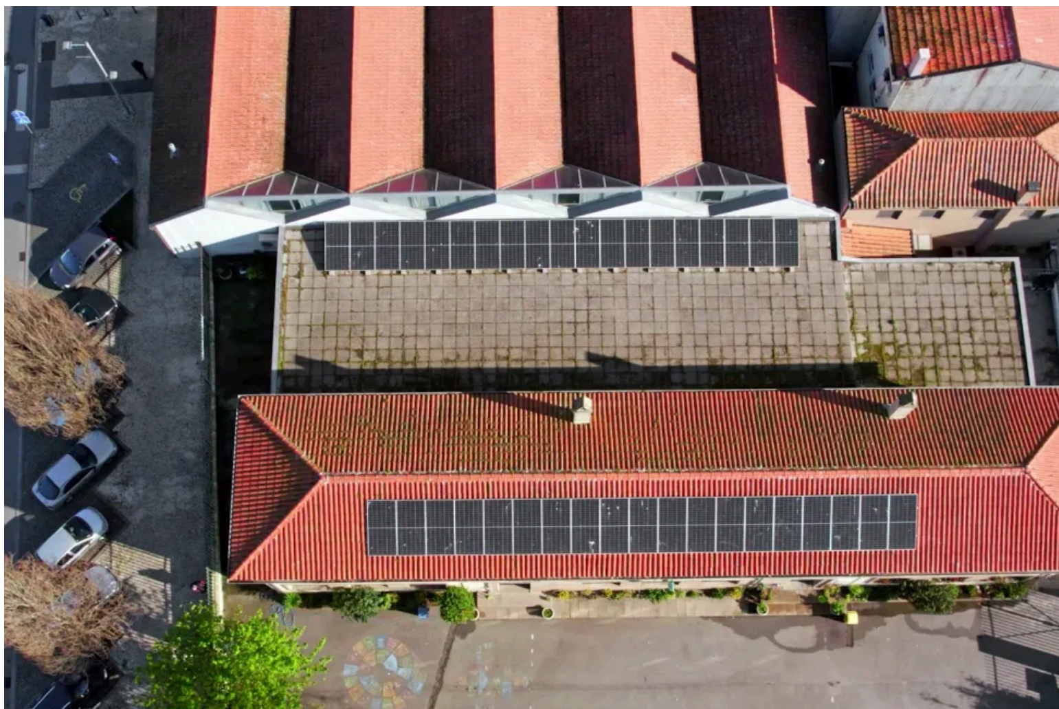
Painéis fotovoltaicos instalados Foto: Direitos Reservados
